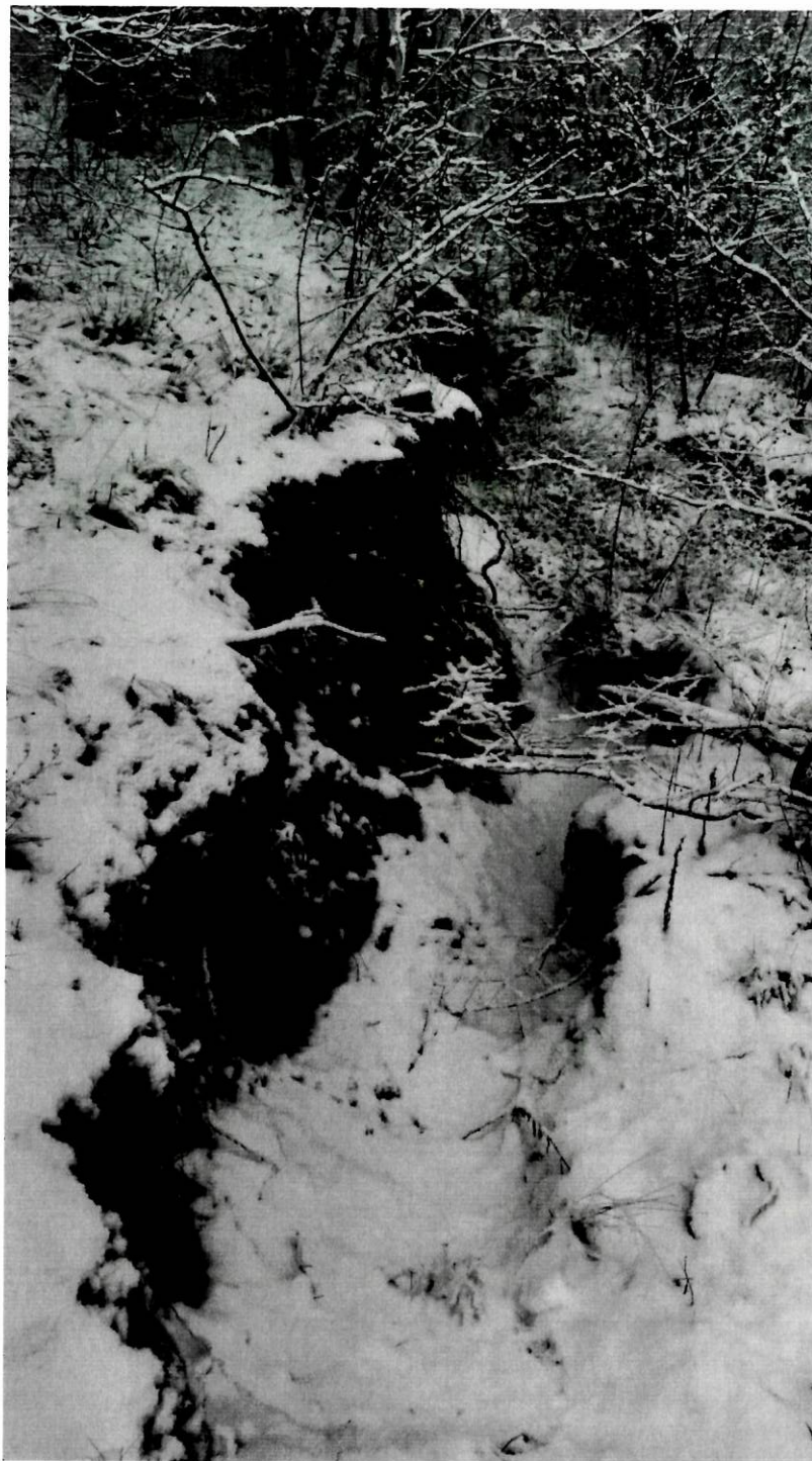
Северо-восточный борт оползня. Оползневые трещины.
